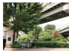
江戸川橋自転車一時駐輪場
